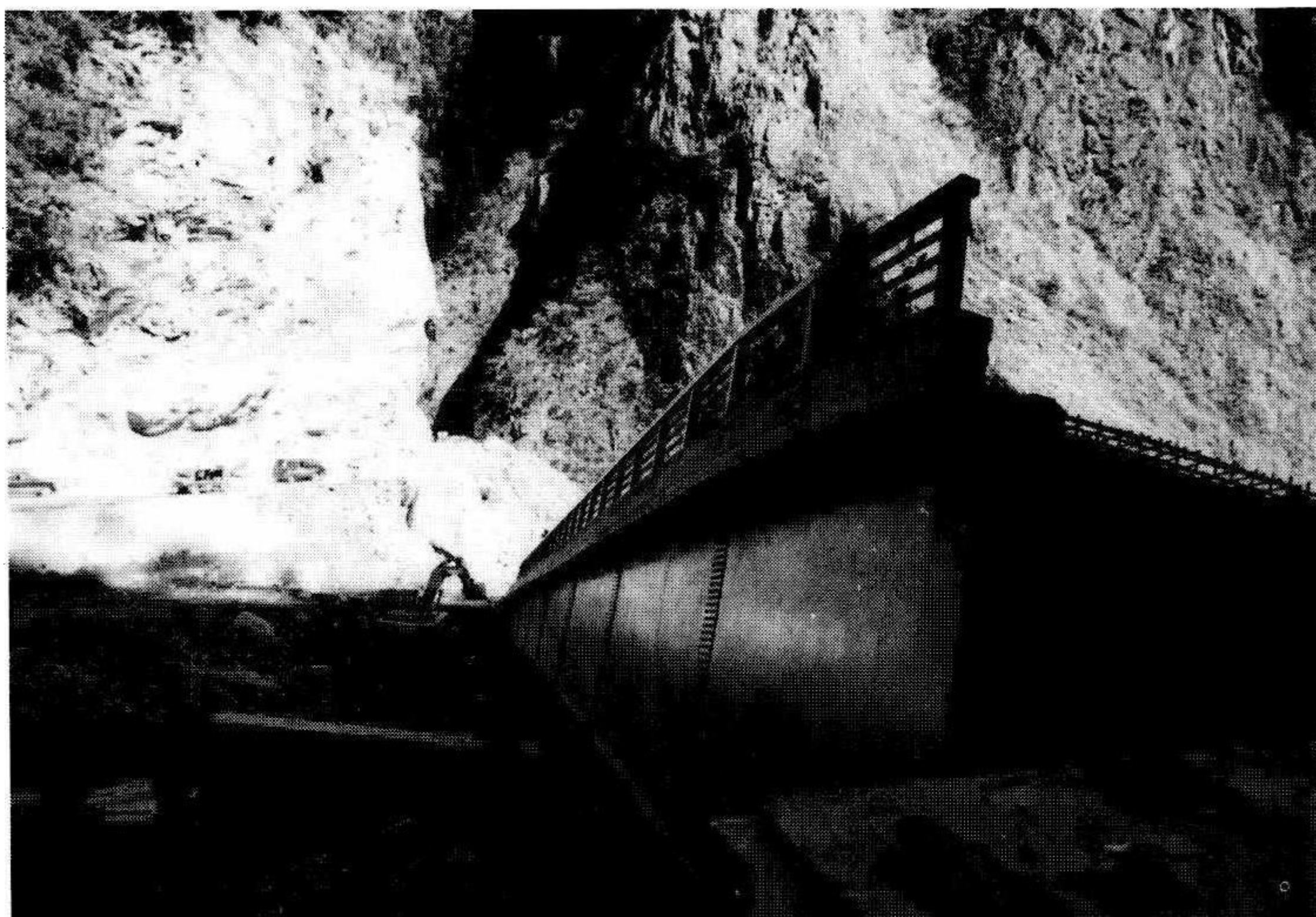
1999年，台湾东部泥石流把巨大的钢梁公路冲塌到河谷中。
